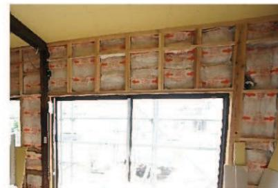
既存の壁の内側に新たな断熱層を設ける付加断熱、既存窓へは内窓を設置、新たに設置した窓には複合樹脂サッシ+ペアガラス(Low-E仕様)を採用、断熱性能を向上させました。
