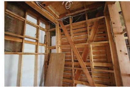
改修工事で既存の壁・天井下地まで撤去し建物の状態をチェック済みです。新しい間取りに合わせて耐震補強も行い「安心安全」な住宅です。
